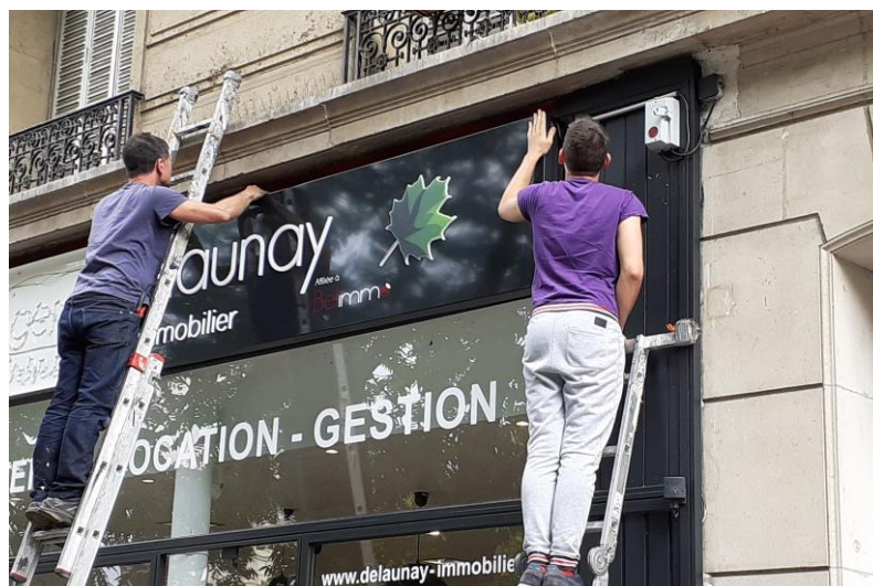
Pose d'enseigne à Paris
